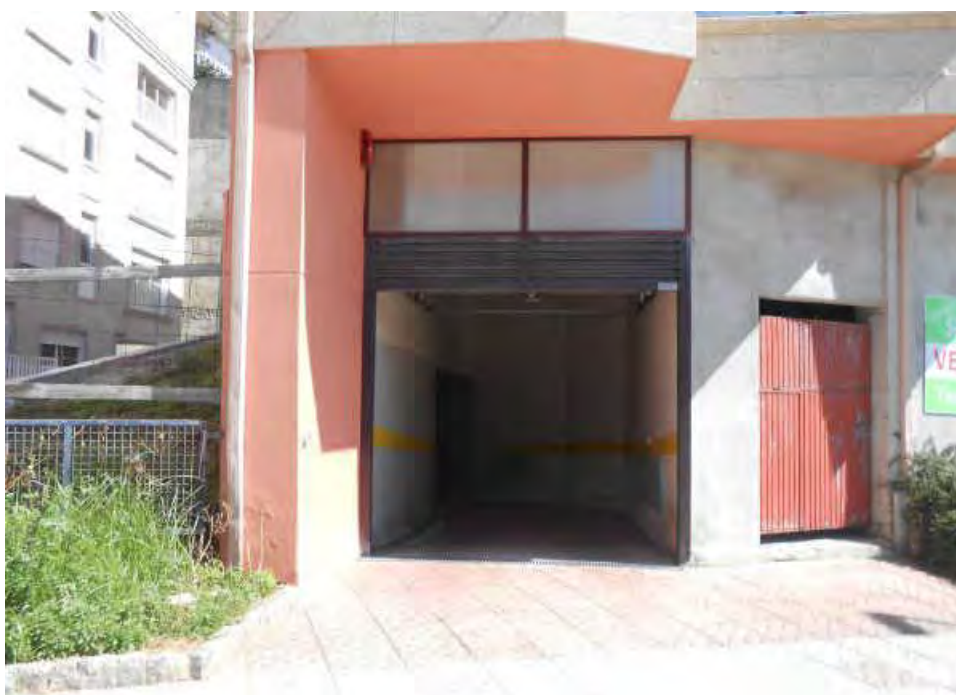
EXTERIOR ACCESO GARAJES
